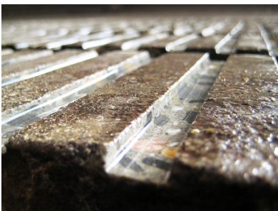
Rainurage de caillebotis avec découpe disques diamant
