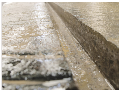
Rainu'Rail , découpe de rainures pour racleurs auto.
